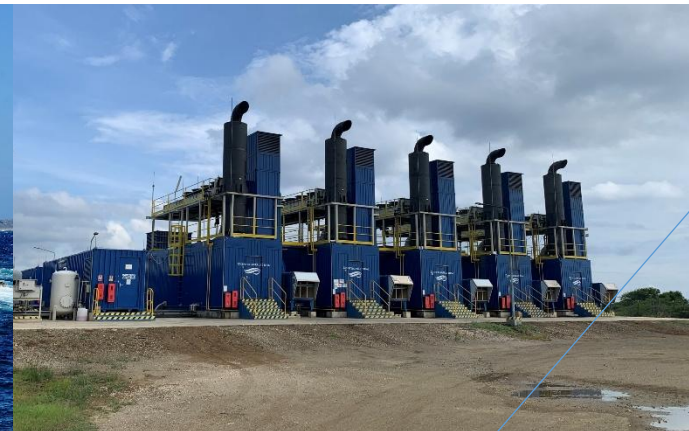
Diesel generatoren
